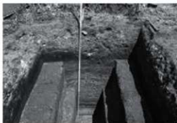
C. 札幌キャンパス避難施設自家発電設備工事 TP 02 北壁 1512
