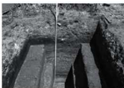
C. 札幌キャンパス避難施設自家発電設備工事 TP 02 北壁 1512
