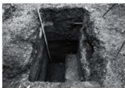
D. 札幌キャンパス避難施設水槽設置その他工事 TP 06 西壁 1515
