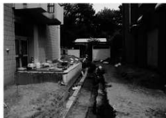
8. 調査区（調査状況：南より）
