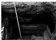
M. 通年型築技施設 (屋内グラウンド) 新営工事 TP 42 南壁 (北から) 0836
