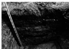
K. 第一農場ブロック塀改修工事 (その2) TP 01 東壁 (西から) 0831
