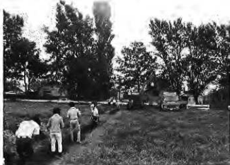
写真-3b 外国人教師宿泊施設建築予定地のトレンチ掘り
