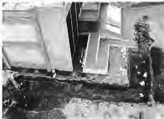
写真-1 附属図書館増築予定地区の調査(西南からみる)
