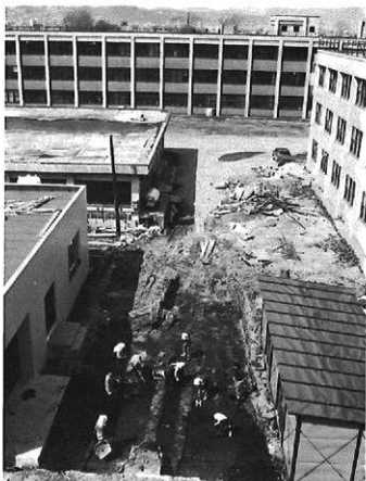
第5図 調査中のヘリウム液化装置室増築地区の写真
