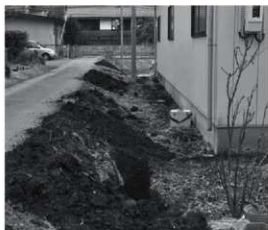
掘削状況（南側）
