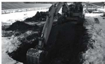
トレンチ掘削状況
