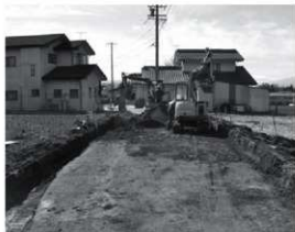
工事掘削状況
