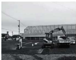
アスファルト除去状況
