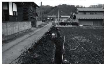
掘削状況（北側）
