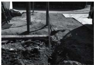
基礎撤去状況
