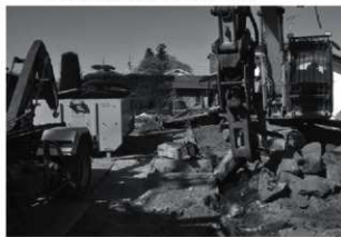
建物解体状況
