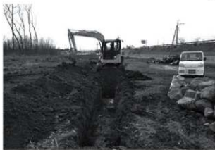
トレンチ掘削状況
