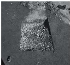
アスファルト除去状況
