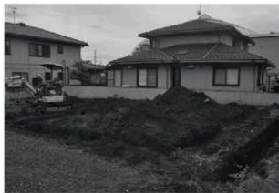
トレンチ掘削状況
