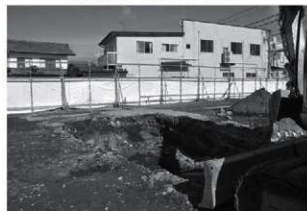
トレンチ掘削状況
