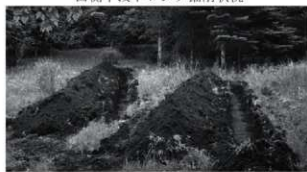
東側トレンチ掘削状況
