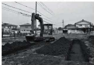
トレンチ掘削状況
