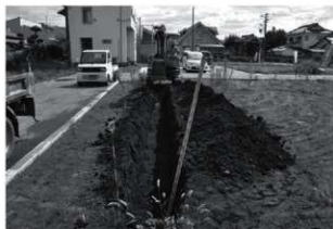
トレンチ掘削状況
