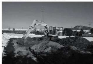
トレンチ拡張状況
