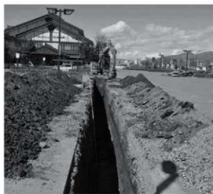
トレンチ掘削状況
