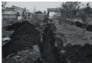
トレンチ掘削状況
