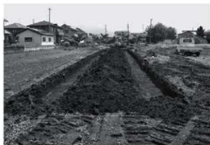
トレンチ掘削状況
