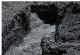
北端トレンチの溝掘り下げ状況
