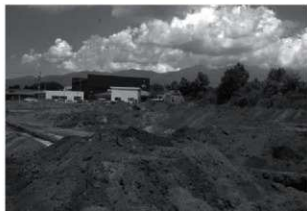
トレンチ掘削状況
