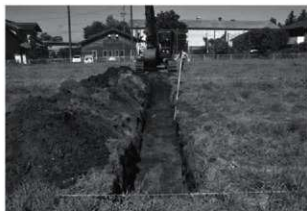
トレンチ掘削状況
