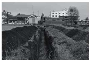
トレンチ掘削状況
