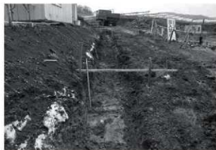
トレンチ掘削状況
