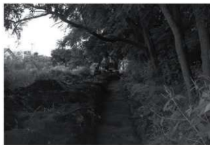
トレンチ掘削状況
