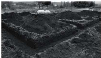
トレンチ掘削状況
