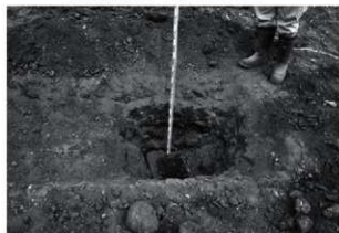
トレンチ掘削状況
