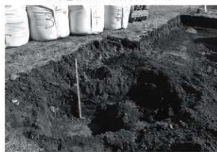
トレンチ掘削状況
