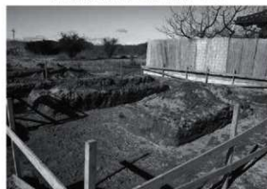
トレンチ掘削状況
