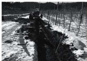
トレンチ掘削状況
