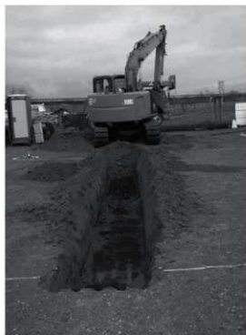
トレンチ掘削状況
