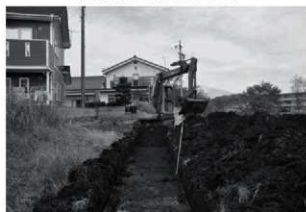
トレンチ掘削状況
