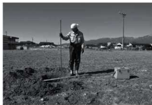
トレンチ掘削状況
