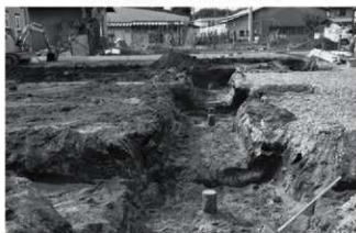
トレンチ掘削状況
