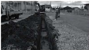
トレンチ掘削状況
