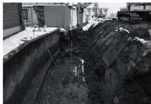
トレンチ掘削状況
