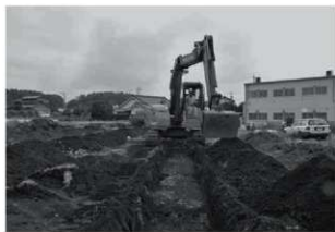
トレンチ掘削状況
