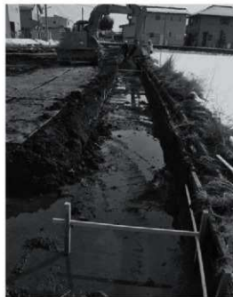
トレンチ掘削状況
