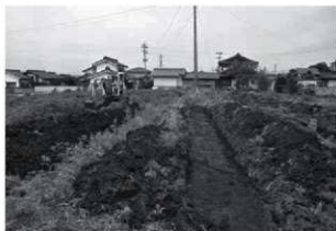
トレンチ掘削状況
