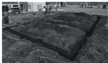
トレンチ掘削状況
