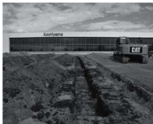
トレンチ掘削状況
