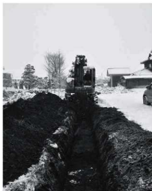
トレンチ掘削状況
