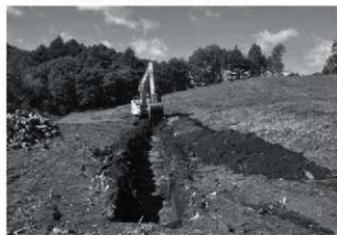
トレンチ掘削状況
