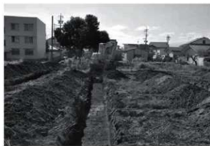
トレンチ掘削状況
