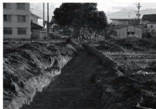
溝状遺構検出状況
