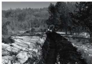
トレンチ掘削状況
