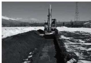
トレンチ掘削状況
