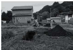
トレンチ掘削状況
