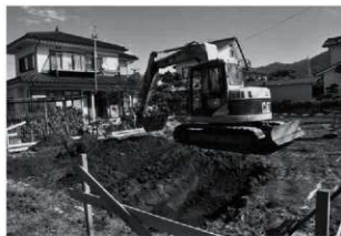
トレンチ掘削状況
