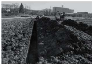
トレンチ掘削状況
