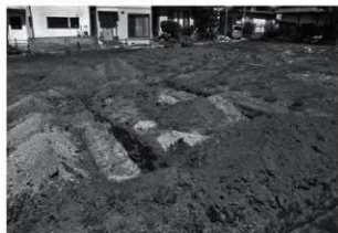
トレンチ掘削状況
