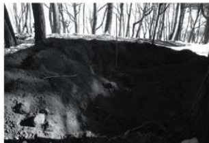
トレンチ掘削状況
