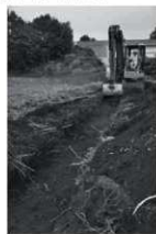
トレンチ埋め戻し状況
