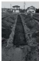
トレンチ掘削状況
