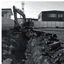
トレンチ掘削状況
