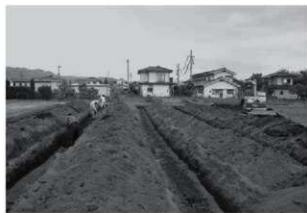
トレンチ掘削状況
