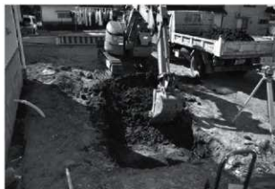
浄化槽設置箇所掘削状況
