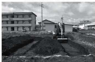
トレンチ掘削状況
