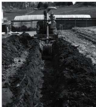
トレンチ掘削状況
