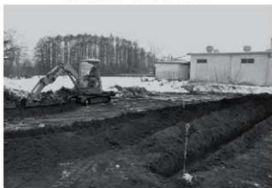
トレンチ掘削状況
