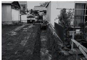
トレンチ掘削状況
