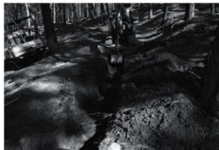
トレンチ掘削状況
