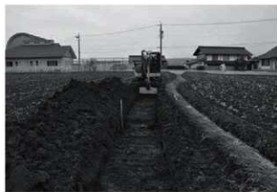
トレンチ掘削状況
