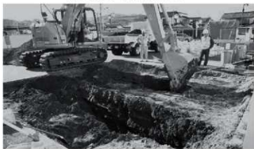
トレンチ掘削状況
