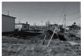
トレンチ掘削状況
