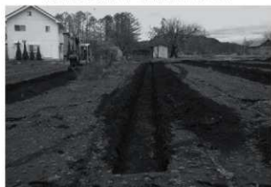
トレンチ掘削状況
