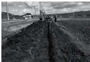
低地トレンチ掘削状況
