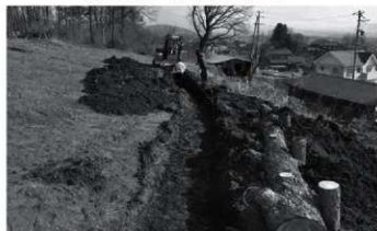
トレンチ掘削状況
