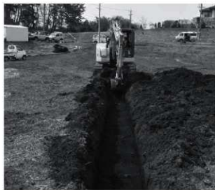
トレンチ掘削状況
