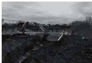
トレンチ掘削状況
