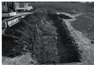
トレンチ掘削状況
