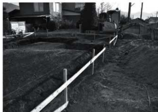
トレンチ掘削状況
