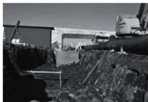
トレンチ掘削状況
