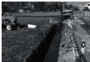
トレンチ掘削状況
