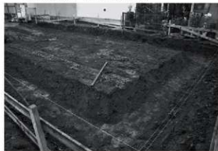
トレンチ掘削状況
