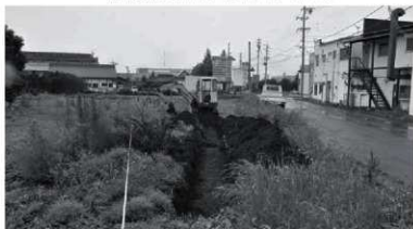
トレンチ掘削状況
