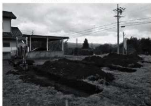
トレンチ掘削状況
