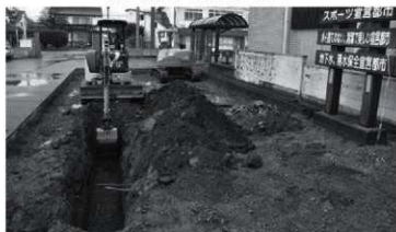
トレンチ掘削状況
