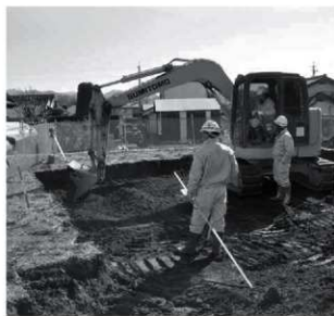
トレンチ掘削状況
