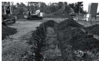
トレンチ掘削状況
