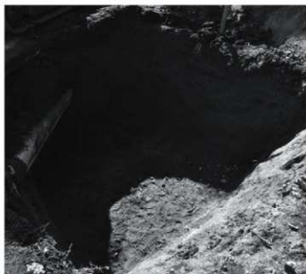
排水橋掘削状況
