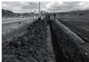
トレンチ掘削状況
