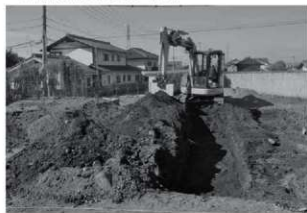
トレンチ掘削状況
