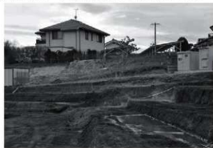
北側斜面地掘削状況
