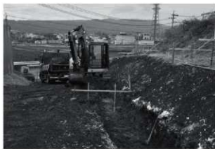
トレンチ掘削状況
