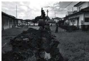
トレンチ掘削状況
