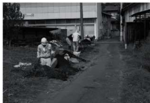
トレンチ掘削状況
