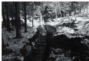
トレンチ掘削状況
