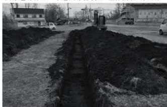
トレンチ掘削状況
