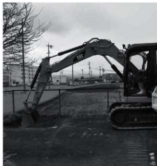
トレンチ掘削状況
