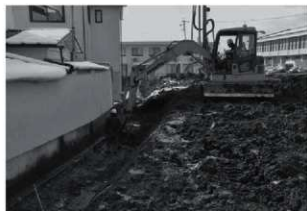
トレンチ掘削状況
