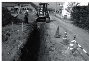
トレンチ掘削状況
