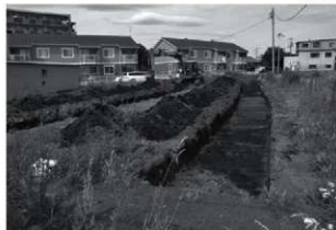
トレンチ掘削状況
