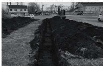
トレンチ掘削状況
