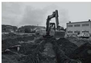
トレンチ掘削状況
