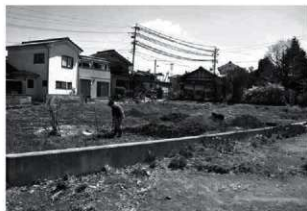
トレンチ掘削状況
