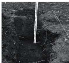
トレンチ掘削状況
