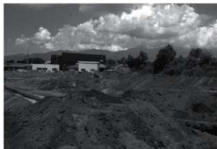
トレンチ掘削状況
