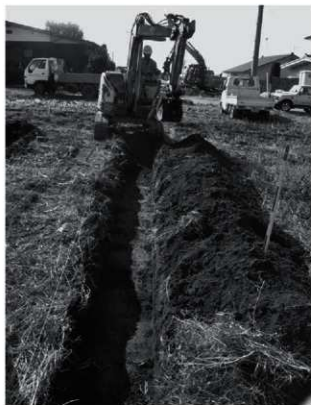
トレンチ掘削状況
