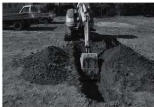
トレンチ掘削状況
