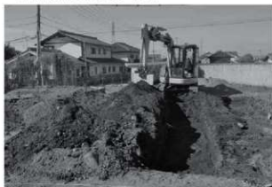
トレンチ掘削状況
