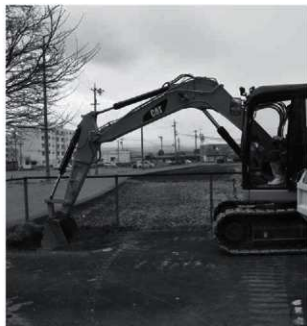
トレンチ掘削状況
