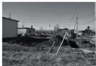
トレンチ掘削状況
