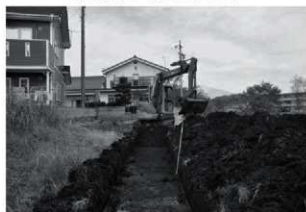
トレンチ掘削状況
