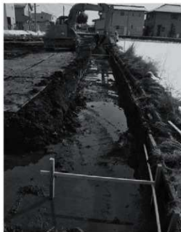
トレンチ掘削状況
