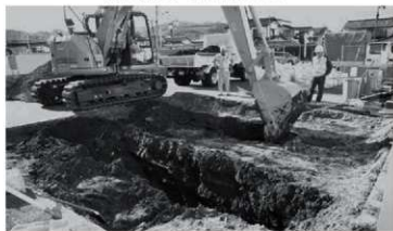
トレンチ掘削状況
