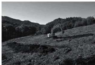
トレンチ掘削状況
