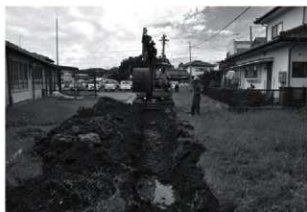
トレンチ掘削状況
