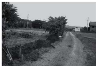
トレンチ掘削状況
