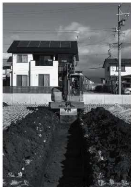
トレンチ掘削状況
