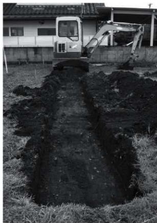
トレンチ掘削状況
