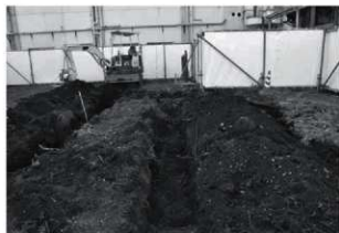
トレンチ掘削状況
