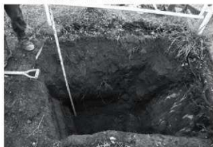
トレンチ掘削状況
