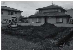
トレンチ掘削状況
