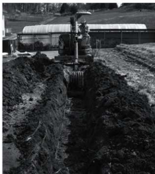
トレンチ掘削状況
