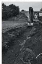
トレンチ埋め戻し状況
