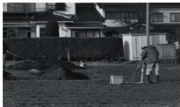
トレンチ掘削状況
