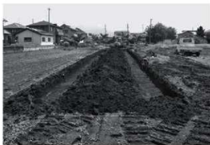
トレンチ掘削状況
