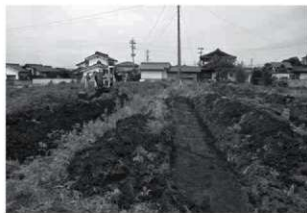
トレンチ掘削状況
