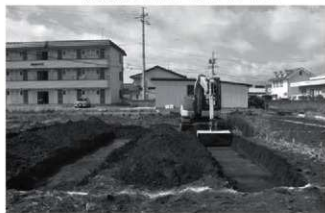
トレンチ掘削状況
