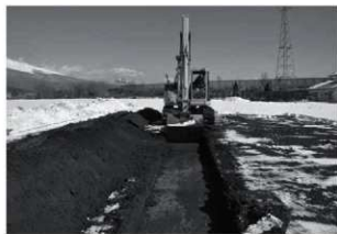
トレンチ掘削状況
