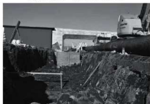
トレンチ掘削状況
