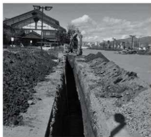
トレンチ掘削状況
