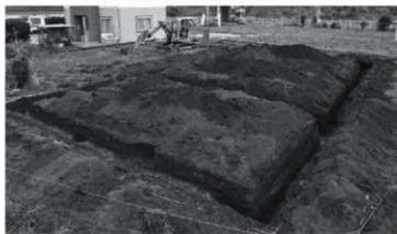
トレンチ掘削状況
