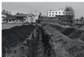
トレンチ掘削状況
