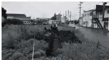
トレンチ掘削状況
