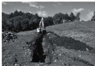
トレンチ掘削状況
