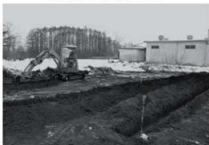
トレンチ掘削状況
