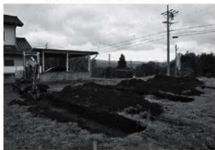
トレンチ掘削状況
