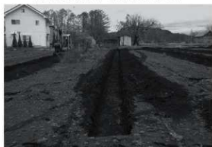
トレンチ掘削状況
