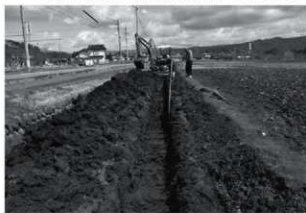
低地トレンチ掘削状況
