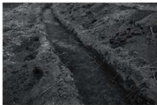
トレンチ掘削状況
