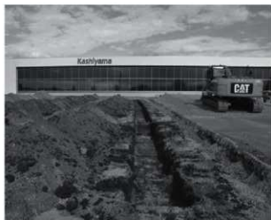
トレンチ掘削状況
