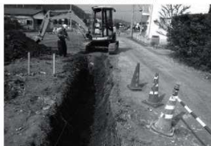
トレンチ掘削状況
