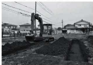
トレンチ掘削状況
