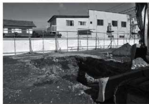
トレンチ掘削状況
