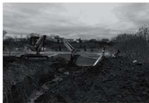
トレンチ掘削状況
