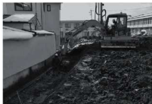
トレンチ掘削状況
