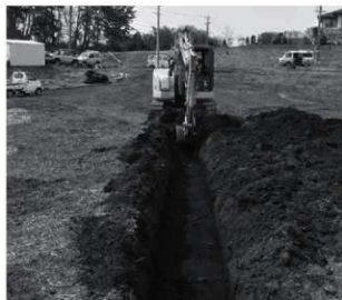
トレンチ掘削状況
