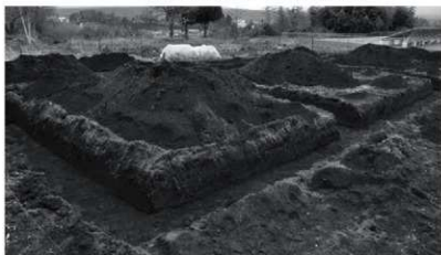
トレンチ掘削状況
