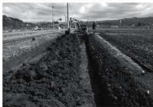
トレンチ掘削状況
