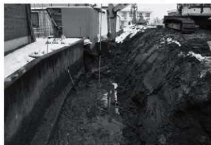
トレンチ掘削状況
