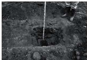
トレンチ掘削状況
