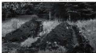
東側トレンチ掘削状況
