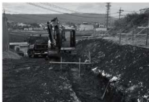
トレンチ掘削状況
