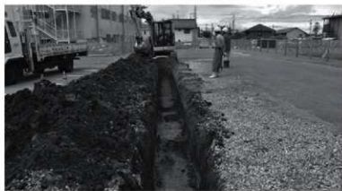
トレンチ掘削状況
