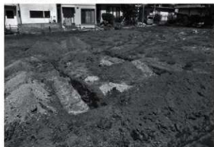
トレンチ掘削状況
