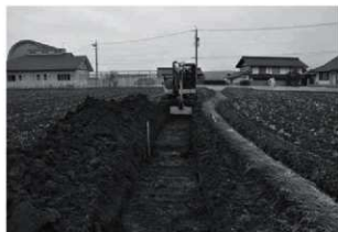
トレンチ掘削状況
