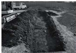
トレンチ掘削状況
