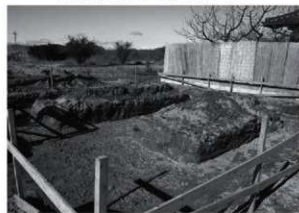
トレンチ掘削状況
