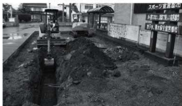
トレンチ掘削状況
