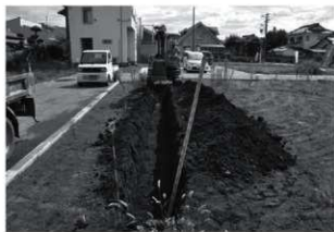
トレンチ掘削状況
