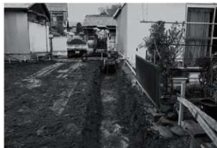
トレンチ掘削状況
