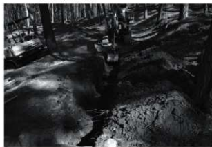
トレンチ掘削状況
