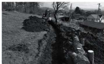
トレンチ掘削状況
