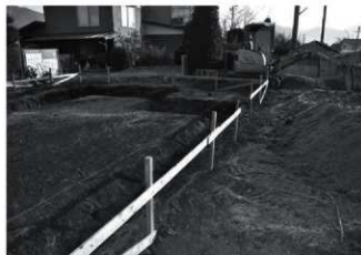
トレンチ掘削状況
