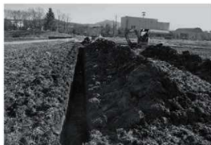
トレンチ掘削状況
