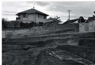
北側斜面地掘削状況
