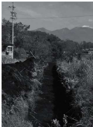
トレンチ掘削状況
