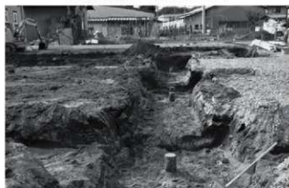
トレンチ掘削状況
