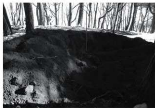
トレンチ掘削状況
