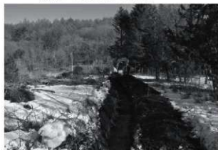
トレンチ掘削状況
