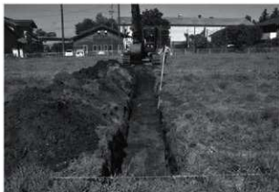
トレンチ掘削状況
