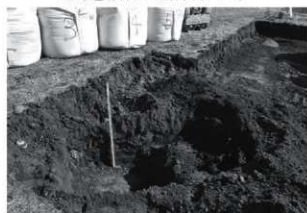
トレンチ掘削状況
