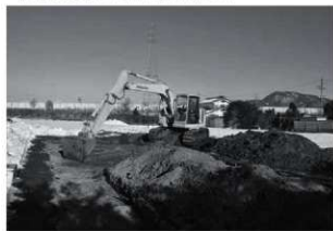
トレンチ拡張状況
