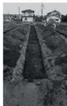
トレンチ掘削状況
