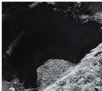
排水橋掘削状況
