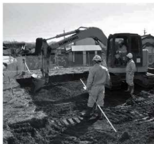
トレンチ掘削状況
