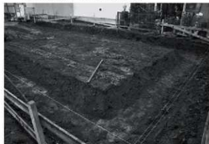
トレンチ掘削状況
