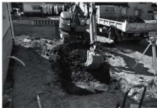
浄化槽設置箇所掘削状況
