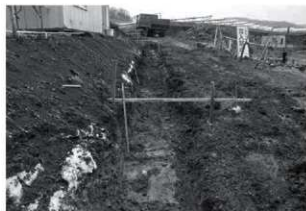
トレンチ掘削状況
