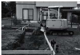
トレンチ掘削状況
