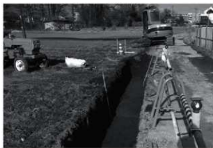
トレンチ掘削状況
