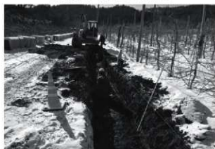
トレンチ掘削状況
