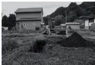
トレンチ掘削状況
