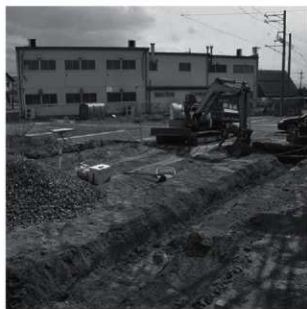
トレンチ掘削状況
