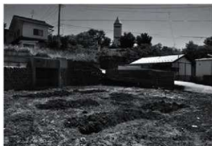
トレンチ掘削状況
