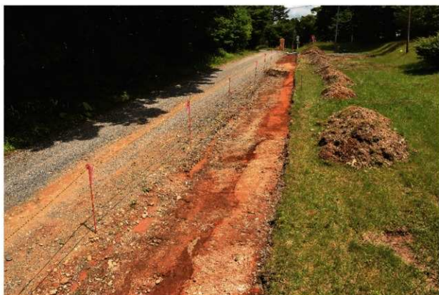
岩洞湖遺跡第2次調査区全景2(西より)
