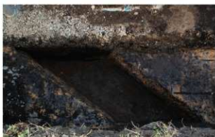
Ⅳ区側溝工事 RG091 大溝跡
