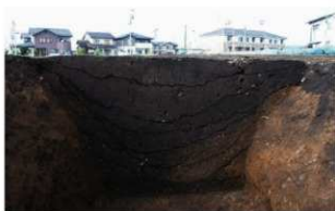
RG091 南部土層断面 (南西から)
