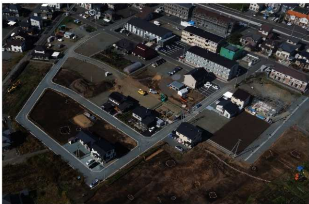
Ⅱ 西区・Ⅲ区全景（南東から）
