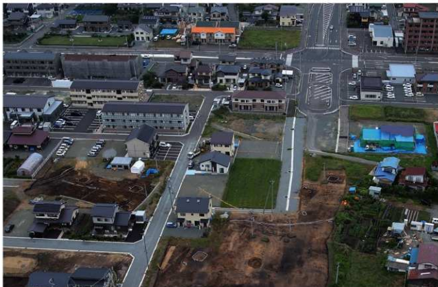
I区北部・II東区全景（南から）
