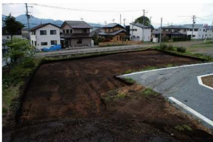
第32次調査Ⅱ区全景（南東から）
