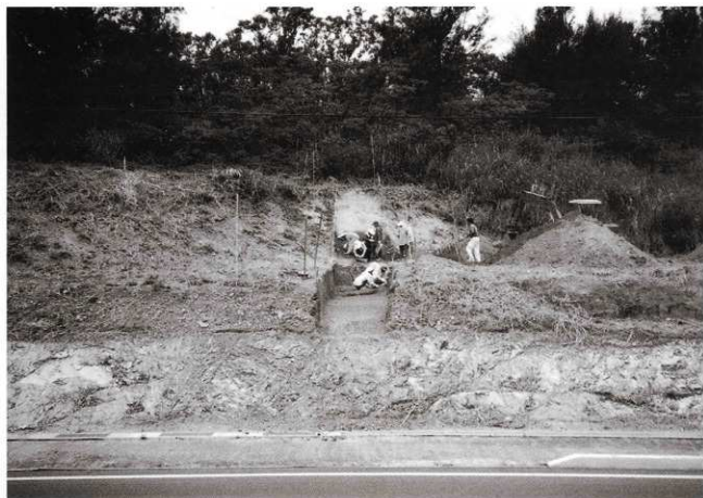
1 トレンチ調査風景
