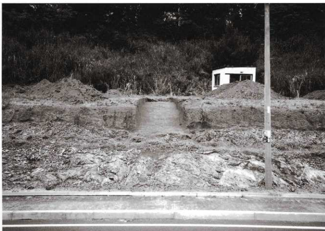
2 トレンチ完掘
