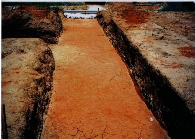
3 トレンチ完掘
