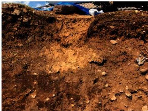
写真16 相原廃寺基壇崩落箇所
