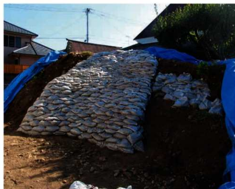
写真17 相原廃寺土のう保護状況
