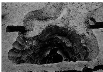
8下SE206横出状況 (北東から)
