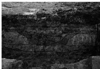
SD1Bセクション (東から)
