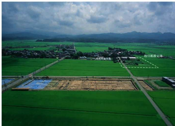
調査区俯瞰全景 (西から)
