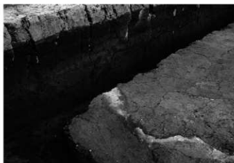
噴砂検出状況 (西から)
