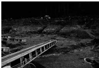
調査区南東側 完掘状況(北西から)
