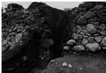
石垣 Cセクション(南西から)
