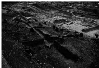
南西斜面部 トレンチ調査状況(南東から)
