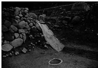
石垣 南隅検出状況(北西から)
