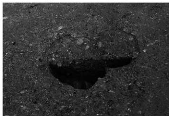
下段上層 P19 セクション (西から)
