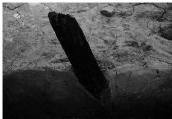
杭118断面(南から)
