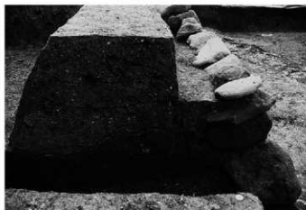
上段南東区画石垣 セクション(東から)
