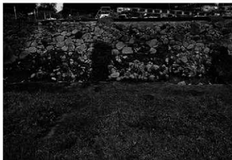
石垣 表土除去後の状況(西から)
