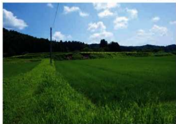
丸山遺跡 被害状況遠景 (北から)
