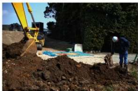
立会箇所③と大土御祖神社（南東から）
