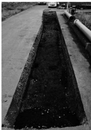
調査区1西部遺構掘削状況 (北東から)
