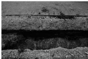
SK41西側肩部 (南東から)
