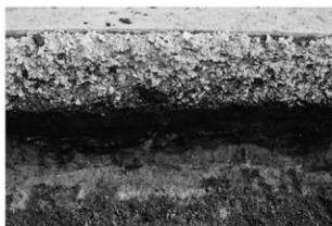
SH9西部土層断面 (北西から)
