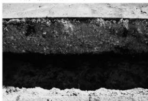
SH10東部 (北西から)
