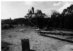
写11 写真撮影（ローリングタワー）
