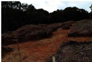
写25 第1次 T-6区 (東から)
