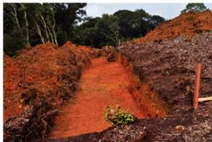
写26 第1次 T-7区 (東から)
