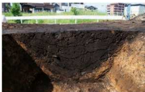
RG091土層断面 (南西から)
