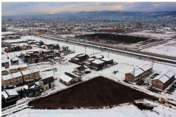
I区全景（南西から）
