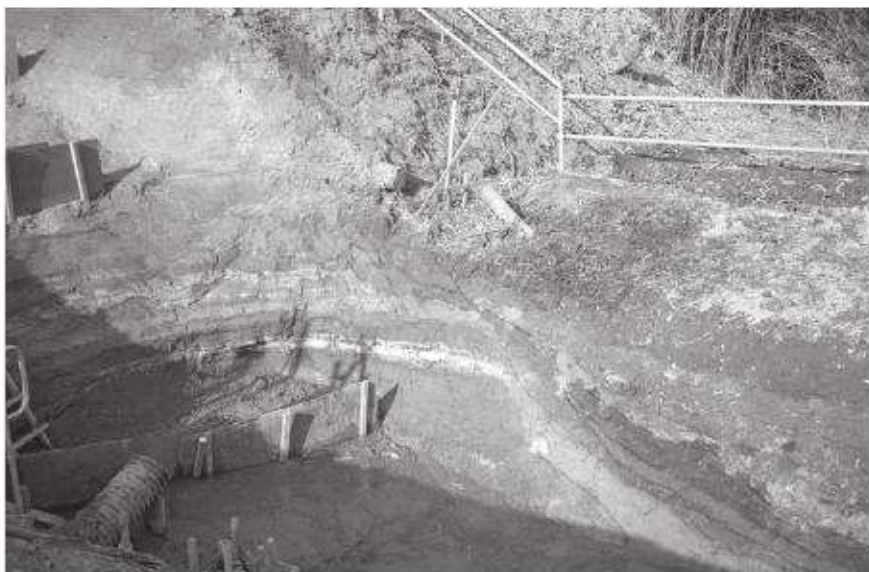
土 層 断 面 Aライン西肩部
