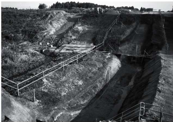
土層断面全景（南西から）
