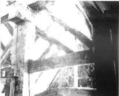
第90図 同 千鳥破風棟木納り状態
