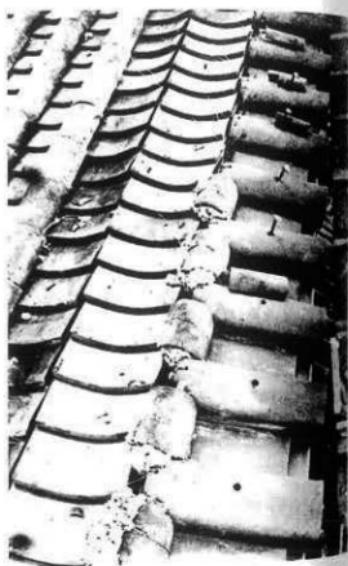
第180図 同 唐破風部の谷の施工状態
