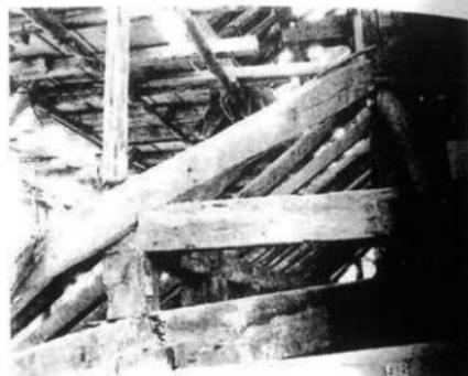
第75図 同 唐破風屋根野樋取付状態
