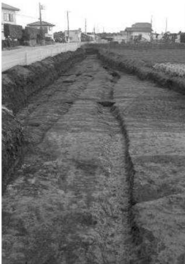
第1号道路跡 側溝1～4 完掘状況
