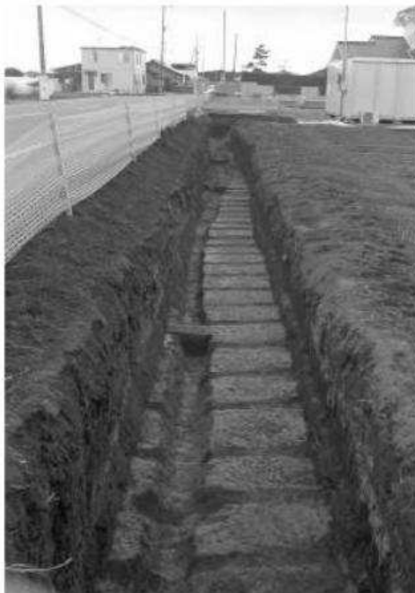
第1号道路跡 側溝5・6 完掘状況
