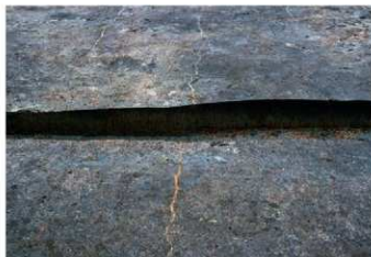
噴砂の検出状況 (19E11 グリッド、西から)
