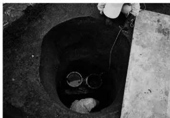
井戸の掘削作業の様子 (SE812)
