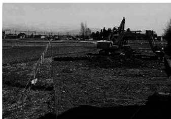
作業風景 (表土はぎ)
