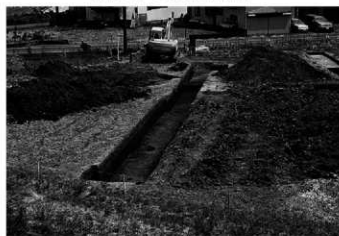
Dトレンチ 完掘 (西から)
