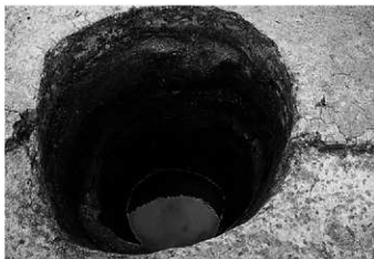
SE154 完掘 (西から)
