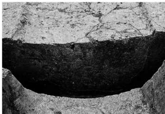
SD133 A-Aセクション (南から)
