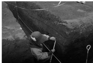
ハケ遺跡第 19 地点調査風景
