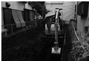
ハケ遺跡第 16 地点調査風景
