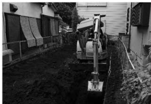
ハケ遺跡第 16 地点調査風景
