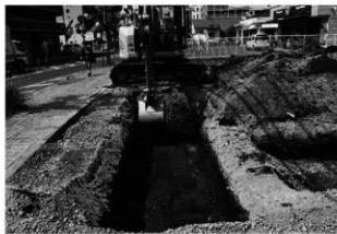
中沢前遺跡第31地点調査風景
