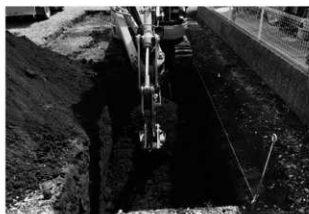
大井宿遺跡第 17 地点調査風景
