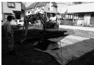
苗間東久保遺跡第31地点調査風景
