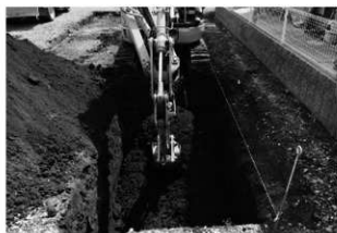
大井宿遺跡第 17 地点調査風景
