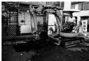
江川東遺跡第 20 地点調査風景
