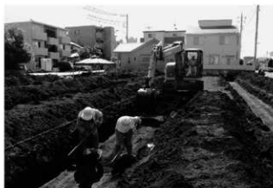
駒林遺跡第31地点調査風景
