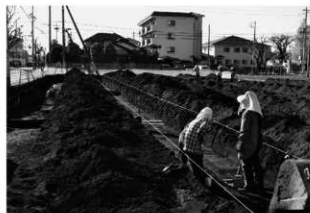
西ノ原遺跡第 156 地点調査風景
