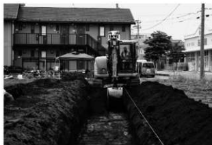
東久保遺跡第 71 地点調査風景
