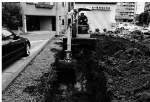
西ノ原遺跡第 155 地点調査風景
