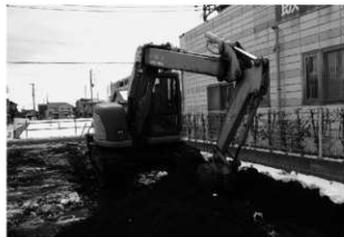
駒林遺跡第32地点調査風景
