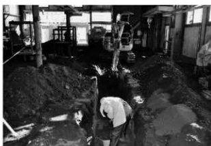
江川東遺跡第 21 地点調査風景
