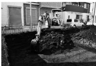
西ノ原遺跡第150地点調査風景
