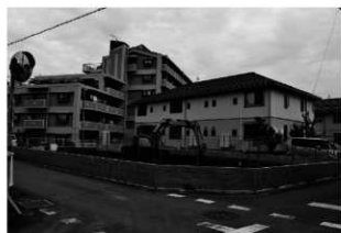
長宮遺跡第 47 地点近景
