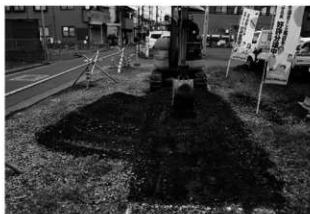
鶴ヶ舞遺跡第 21 地点調査風景
