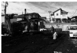
滝遺跡第 23 地点調査風景
