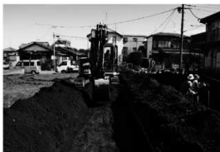
川崎遺跡第40地点調査風景
