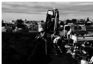
川崎遺跡第40地点調査風景
