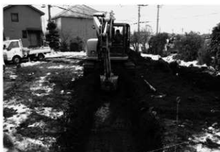
滝遺跡第 23 地点調査風景
