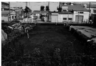
上福岡貝塚第2地点D区土壌置換工事立会い
