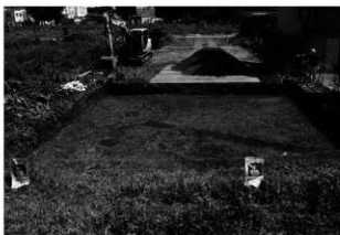
上福岡貝塚第2地点E区土壌置換工事立会い
