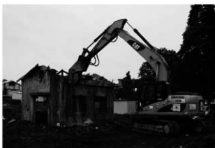
上福岡貝塚第2地点分配室調査風景
