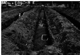
上福岡貝塚第2地点トレンチ5
