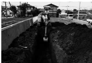
滝遺跡第 22 地点調査風景
