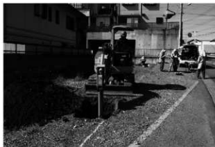
ハケ遺跡第13地点調査風景
