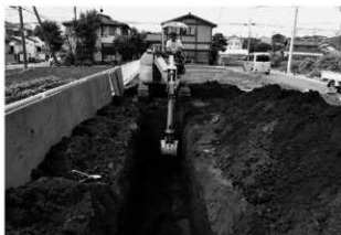
滝遺跡第 22 地点調査風景
