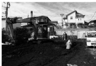
滝遺跡第 23 地点調査風景
