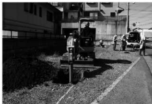
ハケ遺跡第13地点調査風景
