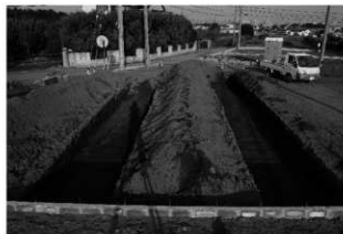
石塔畑遺跡第1地点全景
