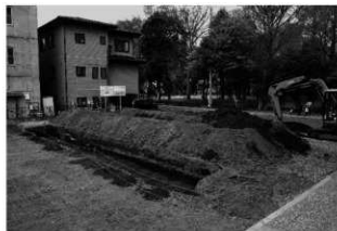
西ノ原遺跡第142地点調査風景
