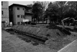
西ノ原遺跡第142地点調査風景
