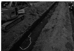
長宮遺跡第 34 地点試掘調査風景③
