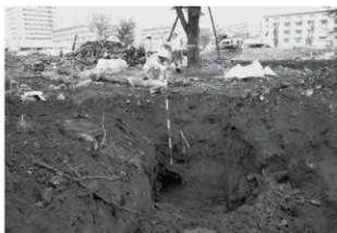
ヒューム管（D区）近景
