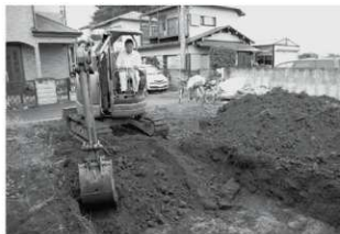
滝遺跡第15地点調査風景
