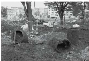
ヒューム管（D区）
