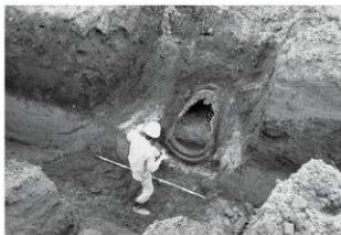
ヒューム管（M区）出土状況
