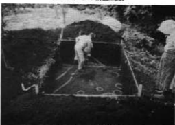
トレンチ4の粗掘風景
