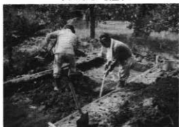
トレンチ1の粗掘風景
