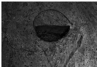
P38 断面 東から
