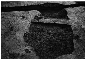
SX161 断面 西から
