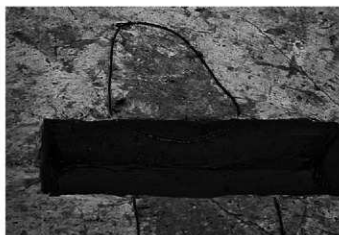
SD29 断面 北東から
