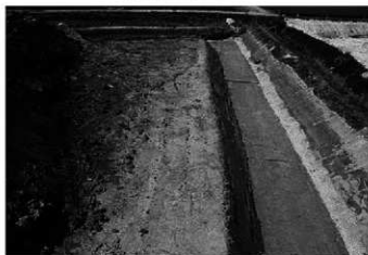
西地区完掘 南から
