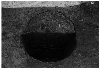
SE397 断面(西から)
