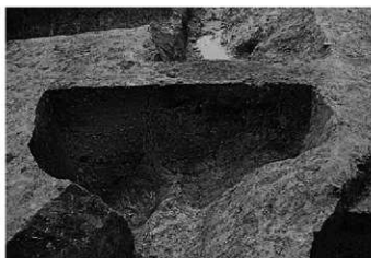
断面 22-SD260・P335 断面(南東から)
