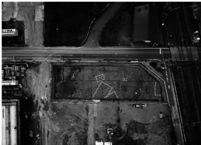
完掘状況 上空から
