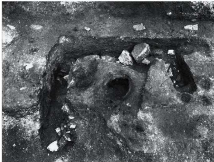
精錬炉2と湿気抜き溝（南から）
