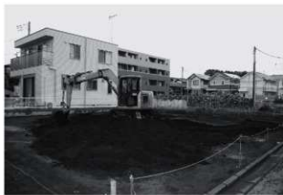
滝遺跡第24地点調査風景
