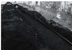
亀居遺跡第74地点トレンチ1
