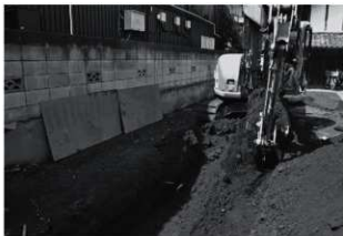
大井氏館跡遺跡第 24 地点調査風景
