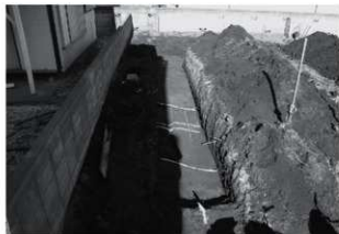
西ノ原遺跡第 163 地点トレンチ 1
