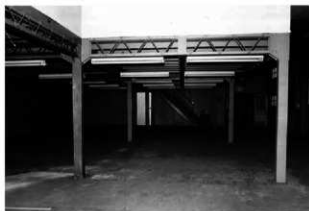
21 軽量鉄骨で2階の床を増築した
