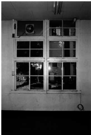
31 北妻壁に残る木製窓
