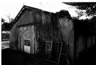
5 北方向から北西面、北東面を見る 両側面は同じ意匠をなす
