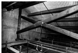
38 屋根は波形スレート葺きでタルキは使わずモヤで直接受けている
