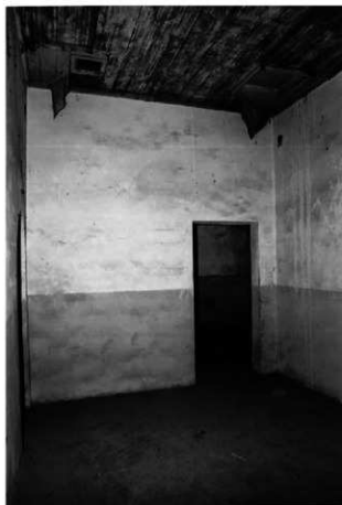
21 作業室窓側から廊下側を見る 天井の高さは約3.5mと高い
