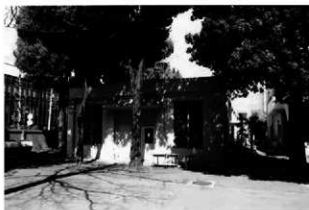
1 電気室南西正面外観
