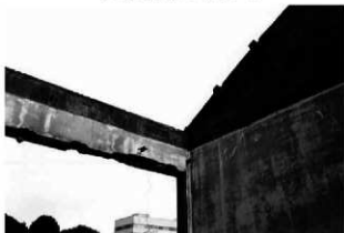
30 外壁上部の梁上の壁 厚みは約 30 cm
