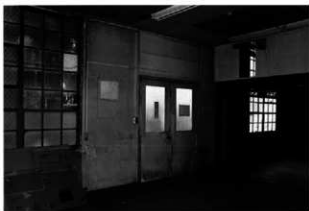
20 電気室内部 正面入口を入った見返し部分
