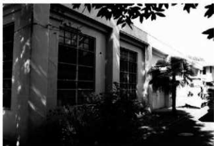
7 東面を南から見る 庇の出ている部分は出入口
