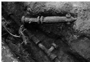
火工廠 消火栓 2
