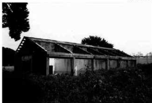
24 屋根と外壁を取り去った爆薬実室 (平成 25 年 8 月 23 日撮影)
