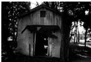
12 北東側妻面 波トタンの庇が付けられている
