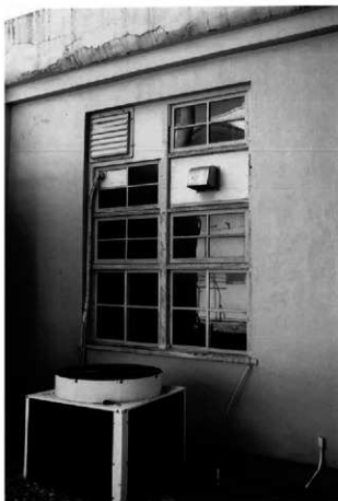
16 同 15 左近景 木製の窓が残る
