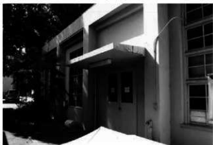
9 南東西側の手前出入口付近
