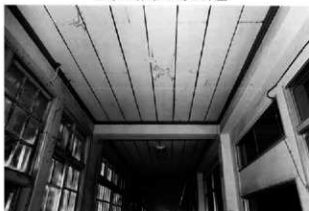
17 廊下の板張りの天井 当初から塗装はされていたが色は不明
