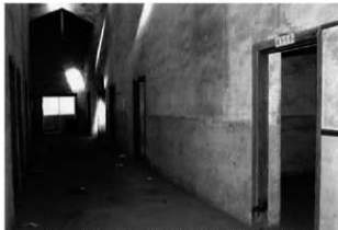
11 中廊下の両側に作業用の個室が並び、間仕切りは分厚いコンクリート製
