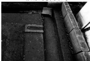
9 壁樋を伝って流れる雨水を受けた石製の受け皿
