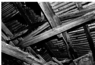
17 小屋組は木製トラスが約2m間隔に 架けられている
