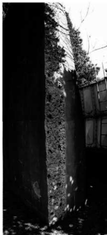
5 防爆壁の切断面
