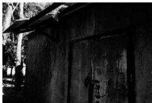
12 庇は鉄骨造 入口扉は木製に鉄板張り
