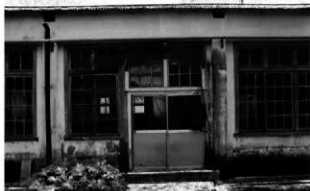
11 同10 壁面の丁度中央の柱間に作られた出入口
