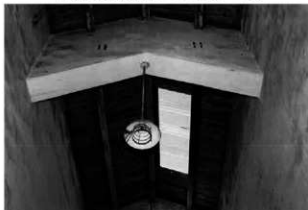
12 廊下の所々に採られた天窗
