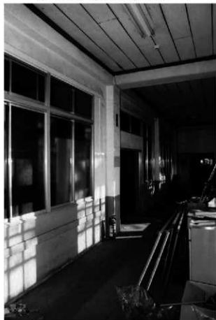
16 同左 廊下と作業室を仕切る壁 大きく改造されている
