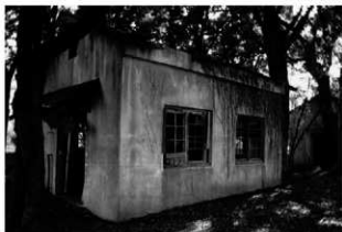
7 北方向から見た全景
