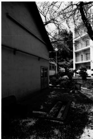
8 同左 反対側から見る かつての下屋の屋根の水切りが見える
