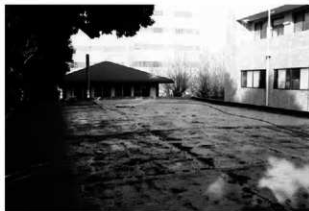
37 屋上アスファルト防水状況 北方向を見る
