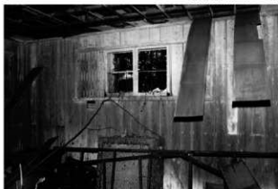
16 火薬倉庫内部 床、天井とも板張りとなる
