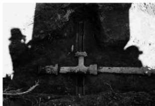
火工廠 配水管
