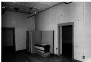
22 同 20 の部屋の廊下方向を見る
