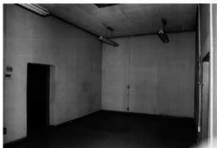
24 同左廊下方向を見る 右手の壁も分厚いコンクリート造
