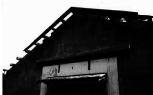
27 同左 モヤの脇に2箇所づつある隙間は小屋裏通気孔
