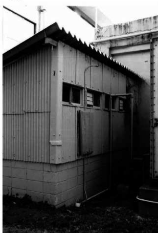
19 トイレ西面（北西面）
