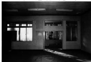
30 29に続く部屋の廊下側間仕切り壁
