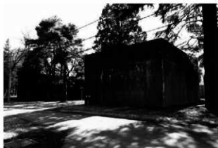
1 防爆壁全景 北方向から見る 鉄筋コンクリート製モルタル仕上げ
