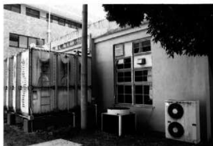
15 電気室北西妻側の外観
