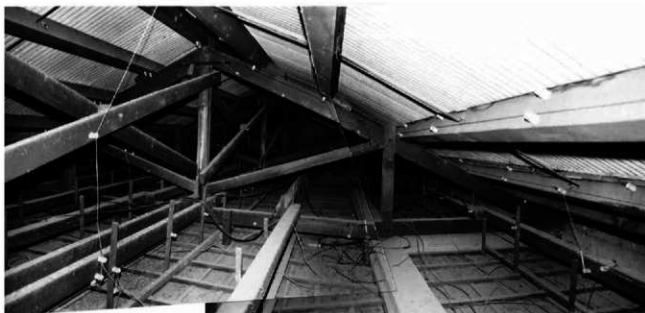
35 小屋組はキングポストトラス構造 モヤには転び止めがつく
