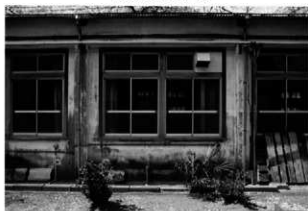
4 南東面の窓 窓枠は鉄板で覆い 再利用している
