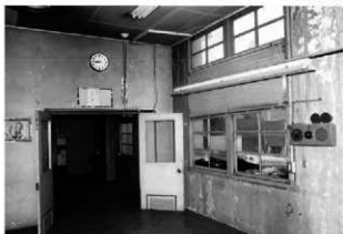
24 同 23 間仕切り部分の近景
