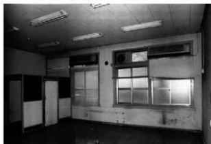
26 同25の部屋の南窓側を見る 一時学校の教室 に改造され使われていた
