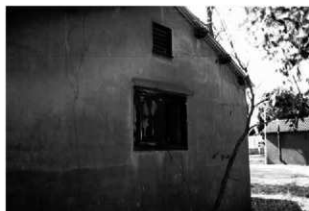
4 北東妻側の庇を伴う窓
