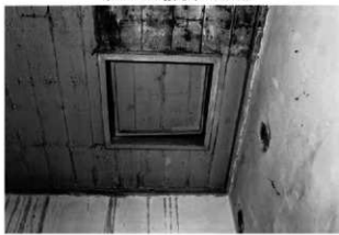
23 天井点検孔 天井板は杉の5分板張り
