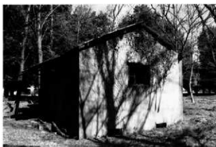
3 西側から見た火薬倉庫全景
