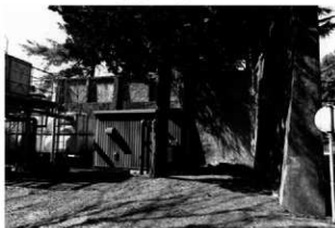
4 防爆壁内側 下半の壁の厚さは約37cm
