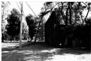
3 防爆壁の断面 柱底部の厚さは約1m程ある
