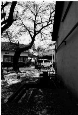
7 東北面妻側の雨水用の排水路は風除室があったことを示している
