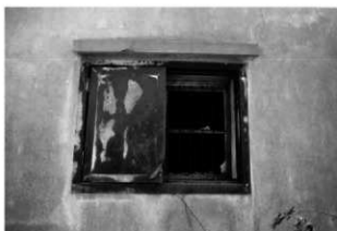
5 同4 土蔵の窓と同じ造り
