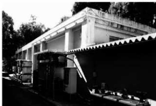
12 電気室を東隅からみる 手前は増築されたトイレ
