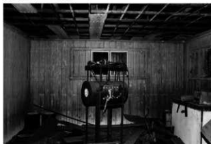
17 北東妻側を見る 小屋組は分配室と同じく木造トラス構造
