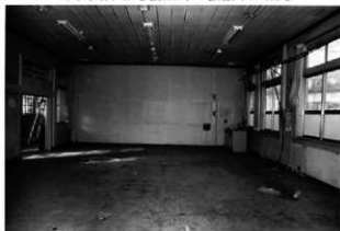
33 29と同じ作業室の北東桁行方向を見る 壁はコンクリート造
