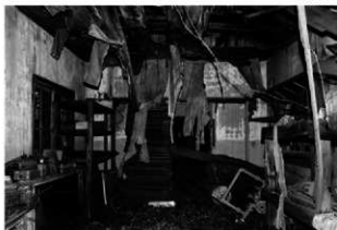
15 室内 南西妻側を見る 床はコンクリートの叩き土間
