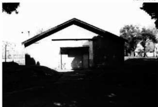
1 南西側正面全景 建物周囲には土塁の痕が確認できる
