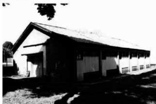
2 南から見た爆薬填実室全景
