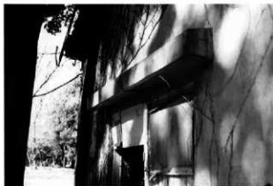
5 入口上部の庇状の突起
