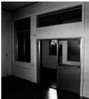
28 廊下境の壁に残る出入口枠と窓枠 ただし建具は不明
