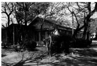
1 南側から見た建物全景 庇のある部分が入り口
