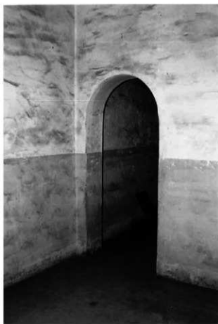
18 作業室をつなぐ通路部分
