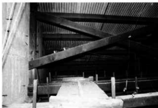
39 トラス相互の桁方向の振れ止め
