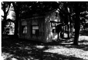
2 分配室北西、南西面外観
