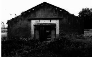
26 南西側正面 もとは風除室が付いていたと思われる
