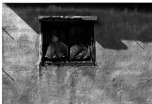
7 同6 南東面の窓近景
