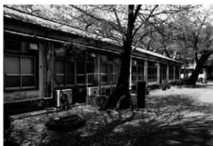
2 南東面 窓はアルミサッシュに 改造されている
