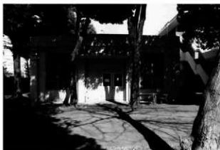
4 南西側正面 窓は金属製
