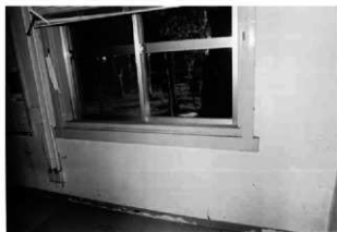
21 南西妻側の窓の一つ もとは木製の窓であった
