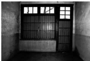
15 爆薬填充室の作業室窓側 各部屋に出入口がつく
