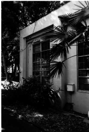
10 南東西側外壁の近景
