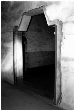
20 改造された作業室への出入口
