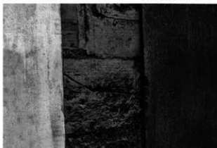
32 内外壁共仕上げはモルタル塗り
