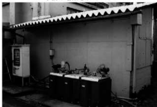
14 トイレ外観 もとは小さいトイレが作られていた
