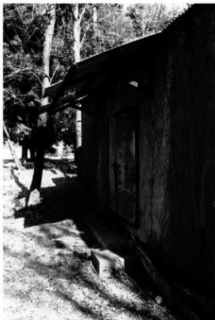
10 火薬倉庫入口付近
