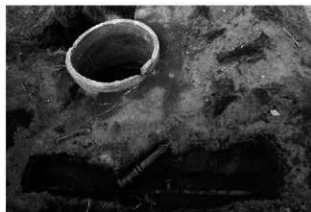
火工廠 水溜 8・消火栓 2
