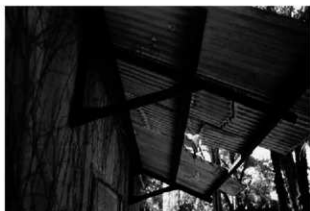
11 入口上部の屋根吹き下ろしの庇 葺き材は波形ストレート
