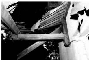
22 庇の持ち送り
