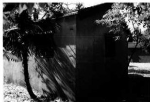
8 東隅部分 壁は鉄筋コンクリート造で屋根は木造となる
