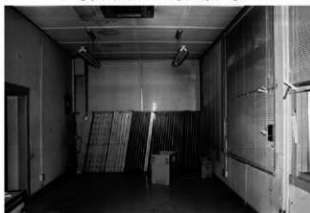
20 作業室内部 もっとも南側の部屋 右手は窓、左はコンクリート造の壁
