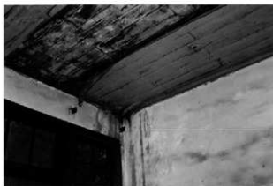
22 作業室天井は埃除けのためか クロスが張られていた
