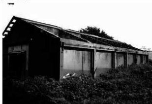
25 同左近景 モヤは切断されているが部分的に残っている
