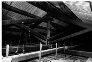
40 同左 小屋材は大部分がボルト止めで止められている
