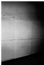
34 同33 正面の壁の中央付近には 出入口が見られた
